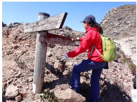
登山道看板の修繕（神津島）
